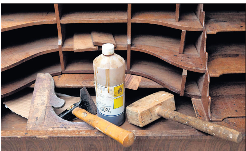
Er wordt gewerkt met ambachtelijk gereedschap.
